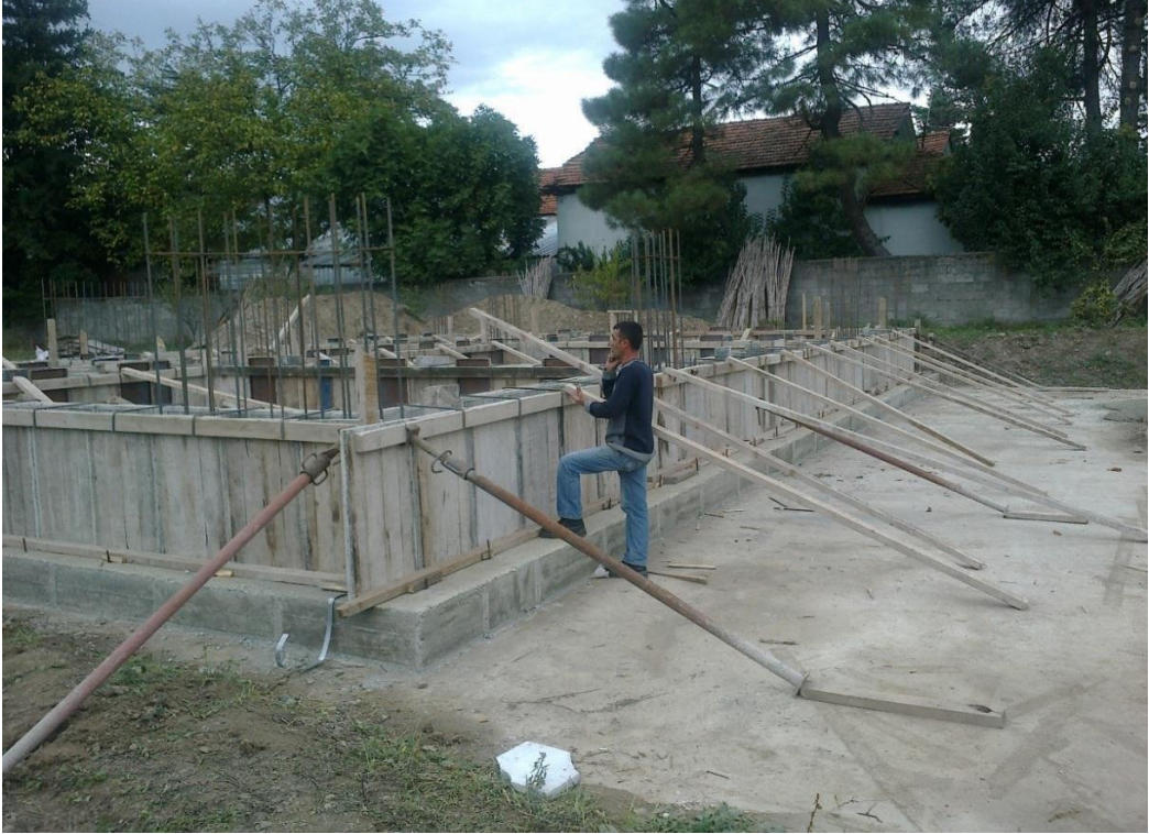
ğekil-59 Temel kalıbına destekler vurulması
