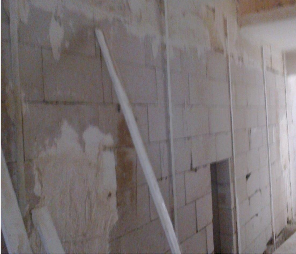
gekil-6 Anoların yapıştırılması
