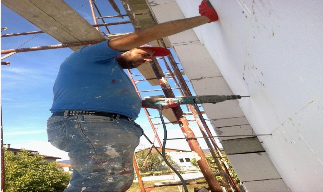
ęekil-29 Köpük için duvar delinmesi
