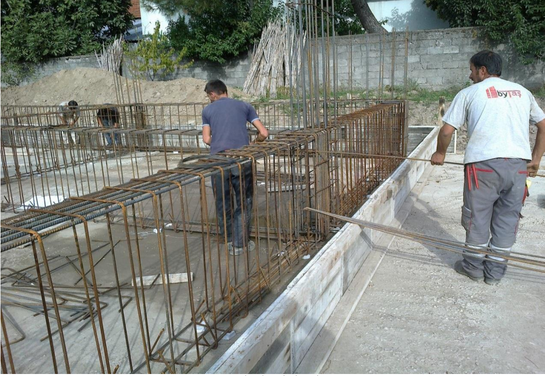
ğekil-52 Gövde demir bağlanması
