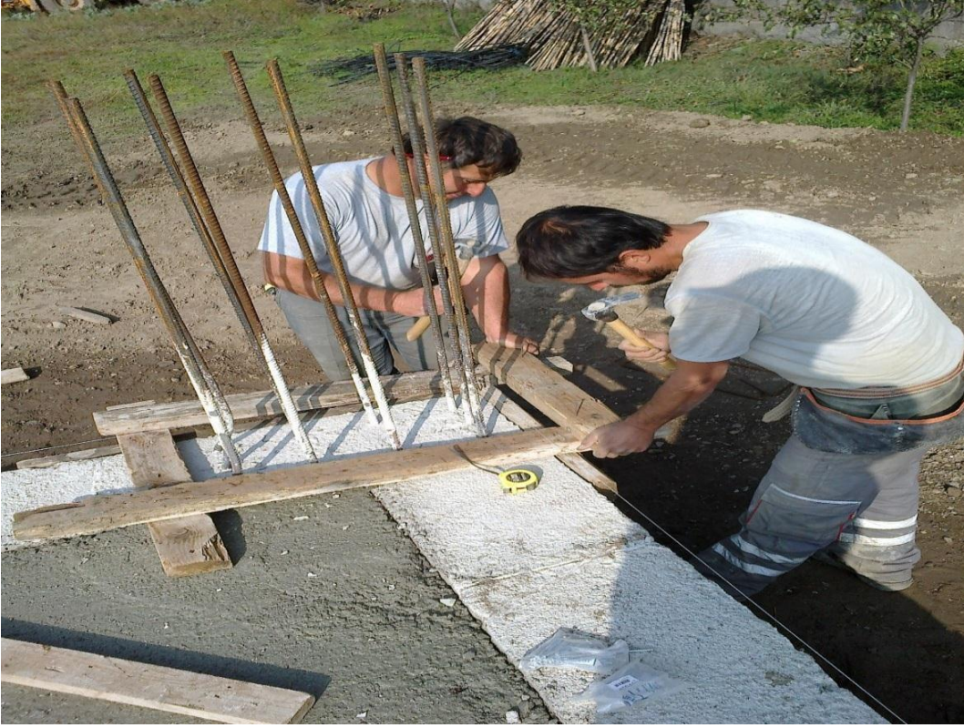
ğekil-66 Kolon akslarının çakılması
