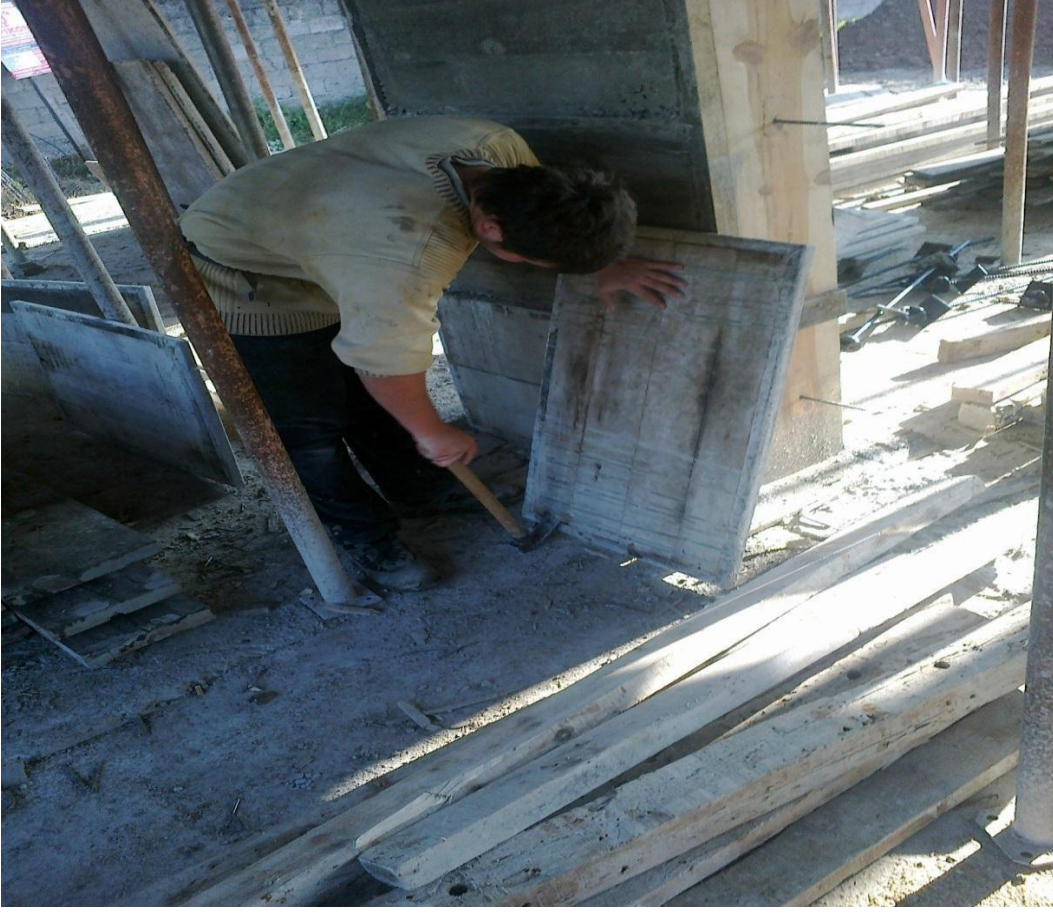
ğekil-80 Kalıp temizlenmesi
