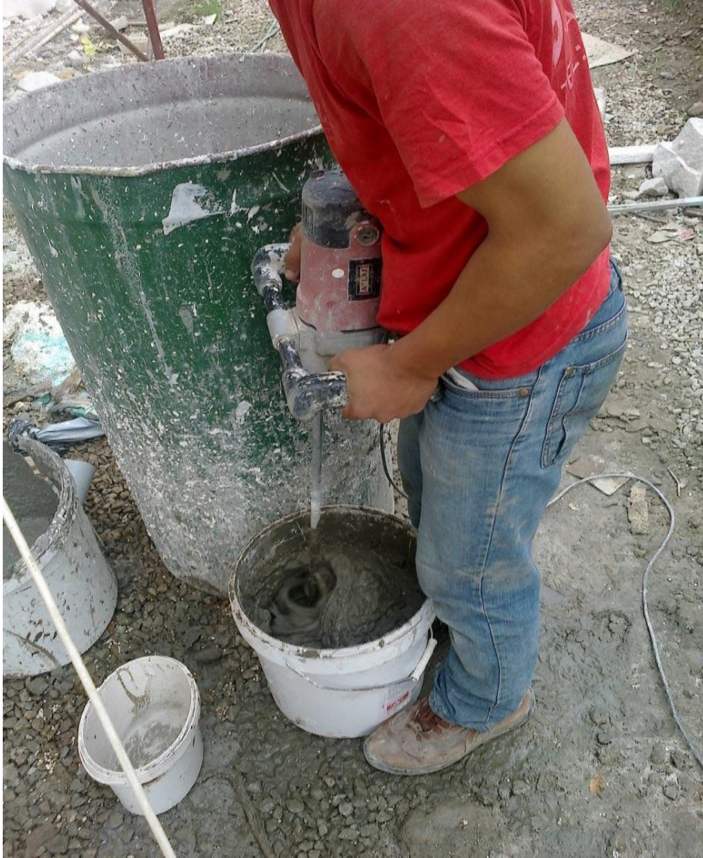
Şekil-31 Harç hazırlanması
