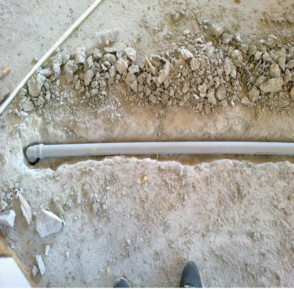
Şekil-26 Teras kat su gideri boru döşemesi
