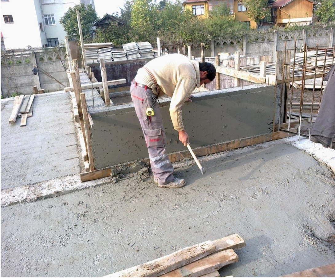
ğekil-63 Perde kanat sökümü
