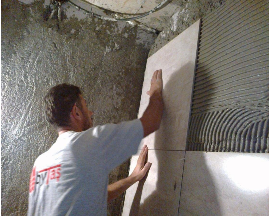
Şekil-16 Fayansın yapıÇtırılması
