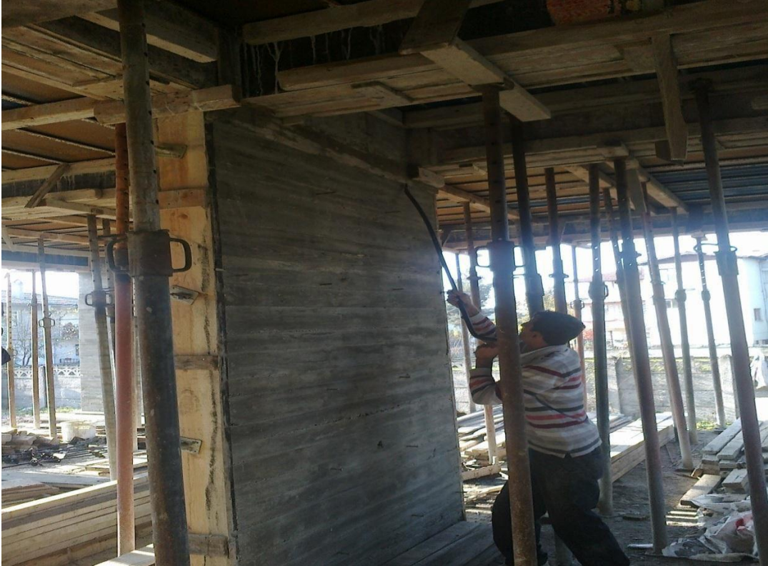
Şekil-77 Kolon kanat sökümü
