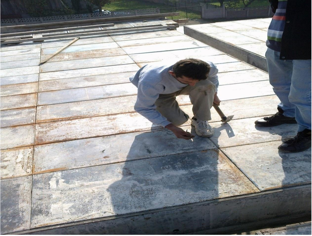
ğekil-72 Pano döÇemesine çiviçakımı
