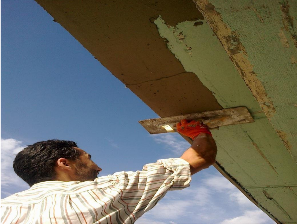
ęekil-45 Yapıřtırıcı sıva yapımı
