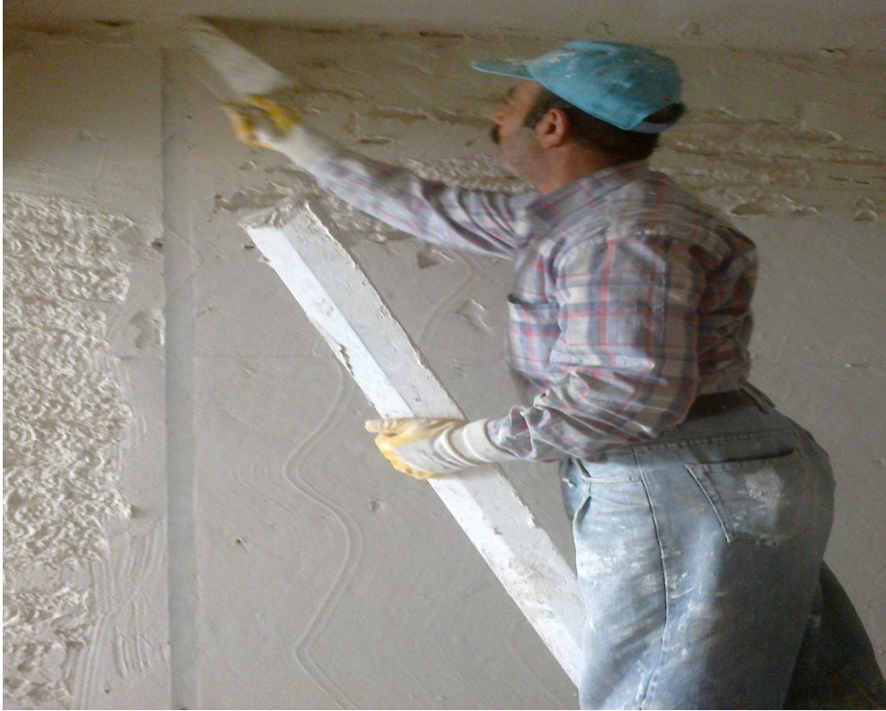
ğekil-8 Mala ile alçı düzeltilmesi
