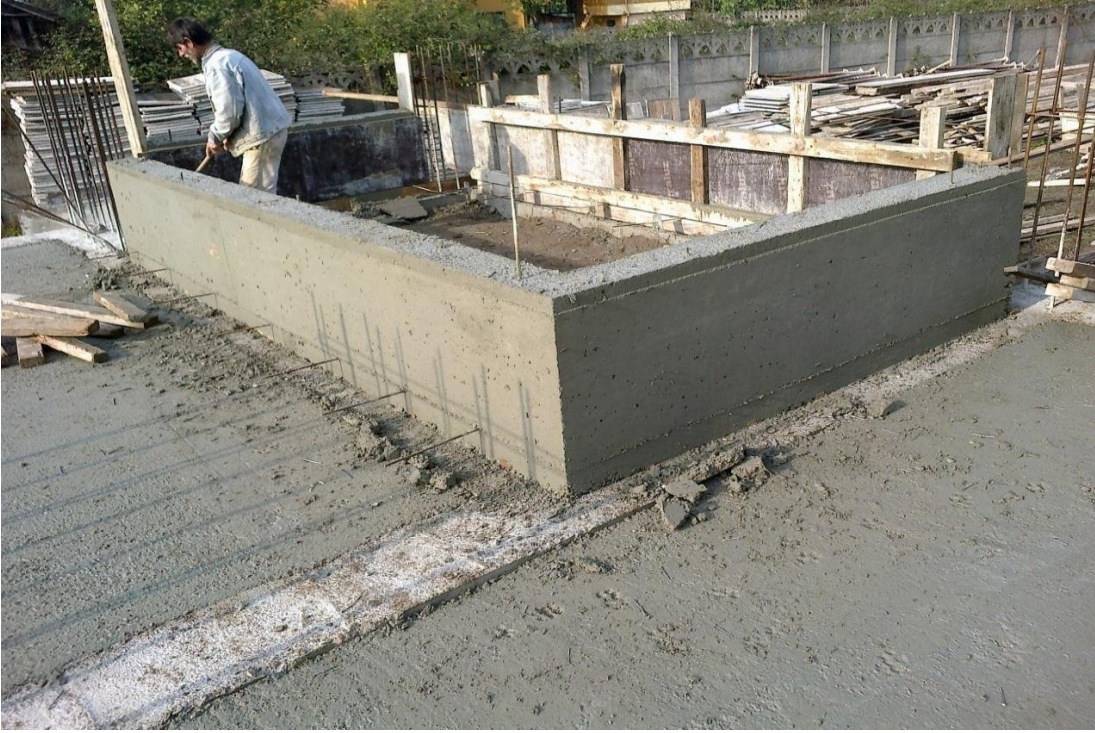
ğekil-64 Perdedeki Ğirozların Ğıkarılması
