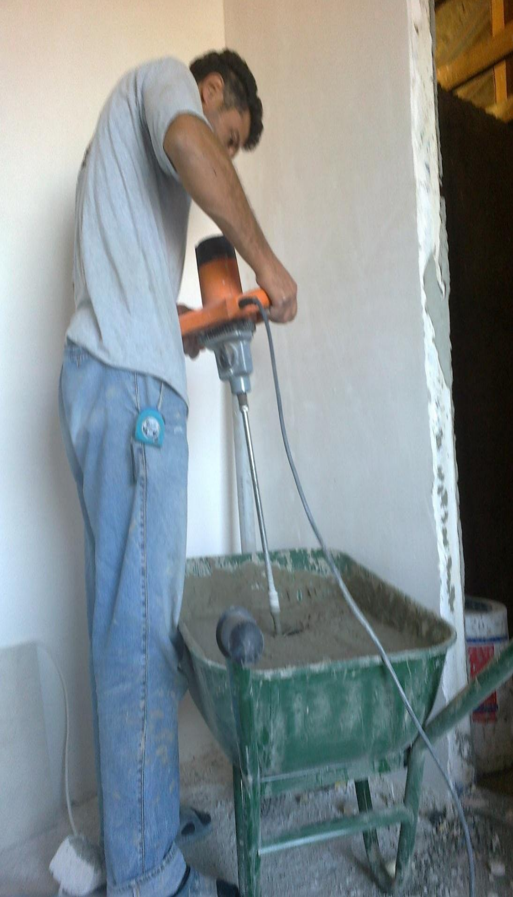
gekil-13 Fayans harcının hazırlanması
