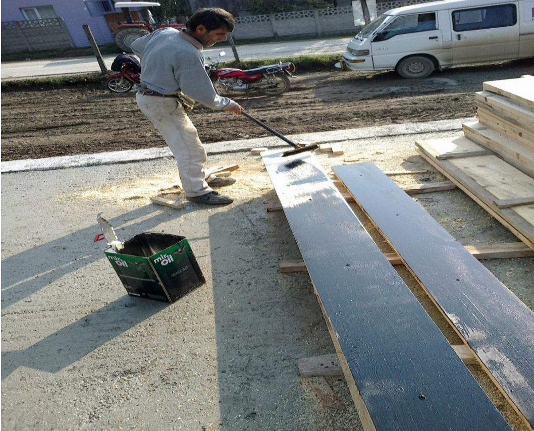
ğekil-67 Yanak kalıplarını yağlanması
