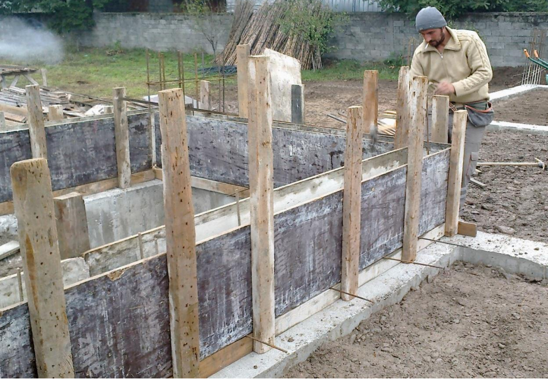
ğekil-62 Perde kalıbaçiroz atımı
