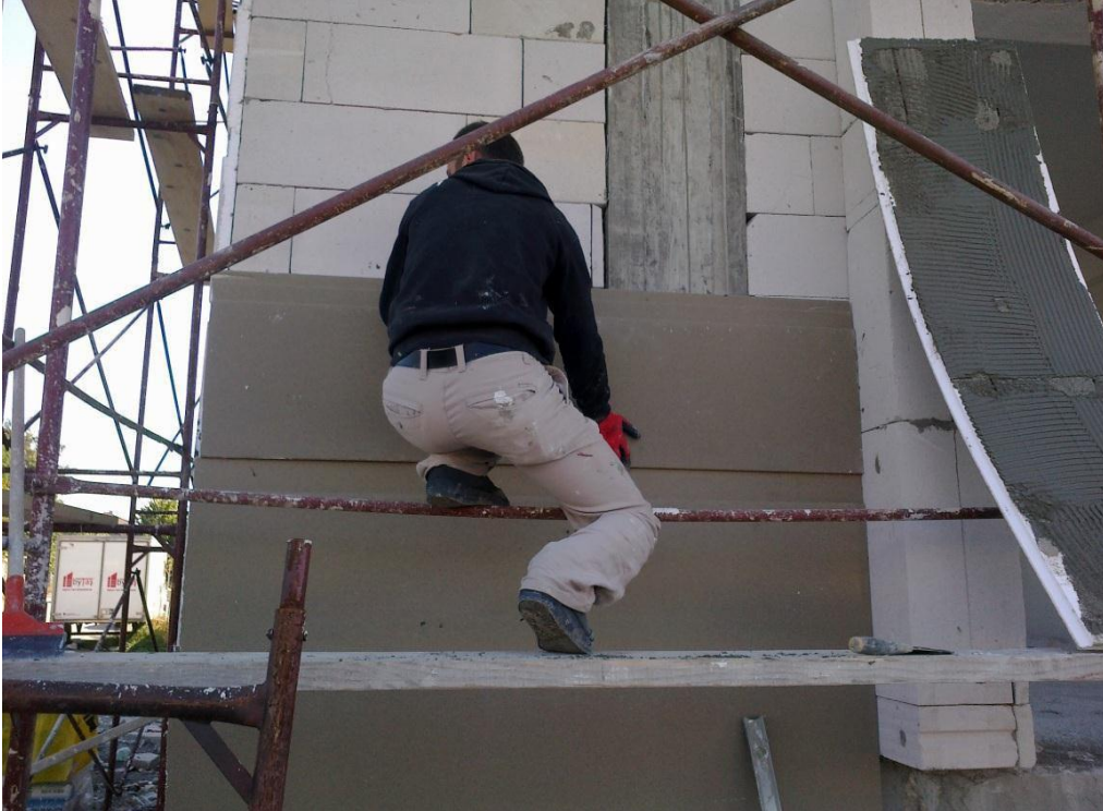
ğekil-28 Fugalı mantolaması
