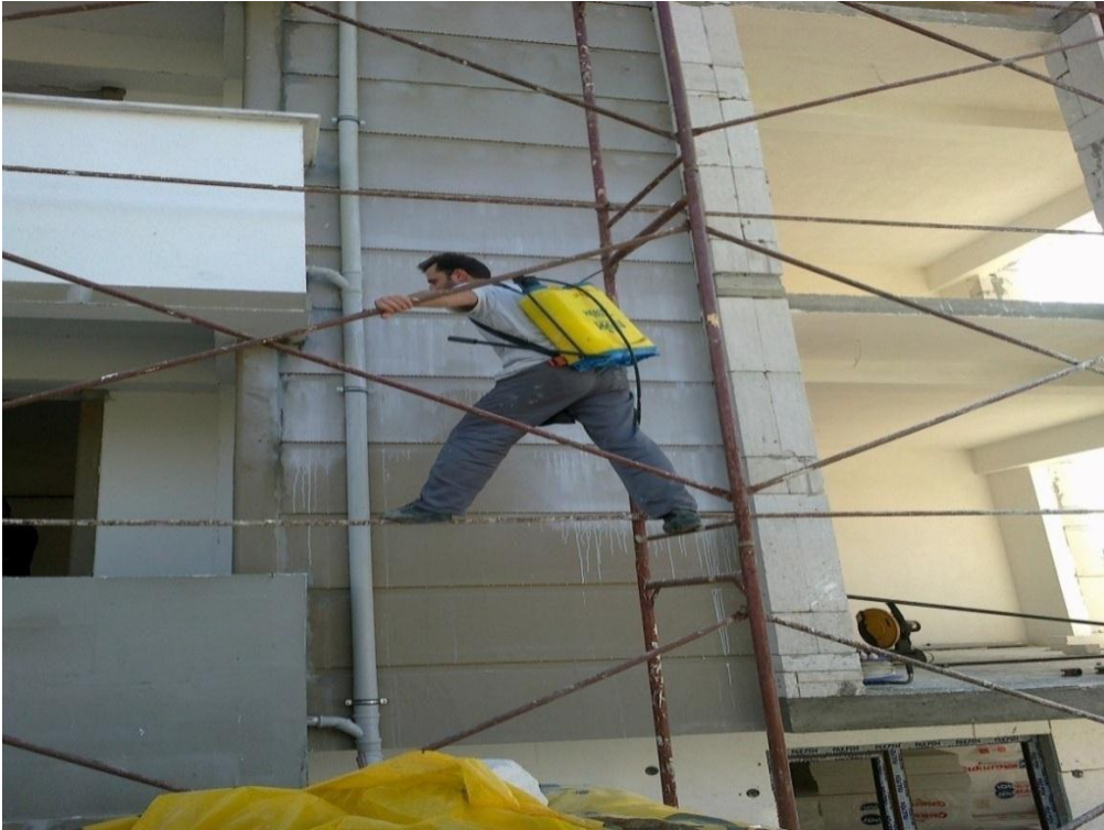
Şekil-38 Yüzey astarlama
