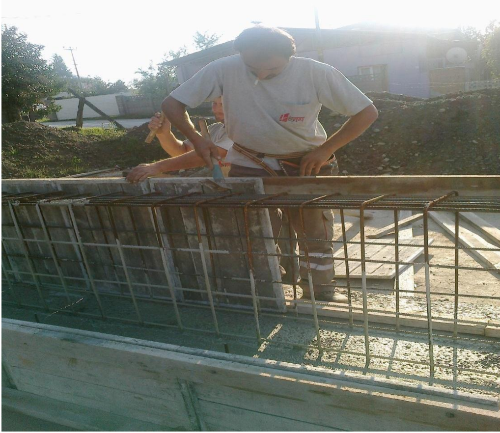
ekil-56 Temel kiri kanat akılması
