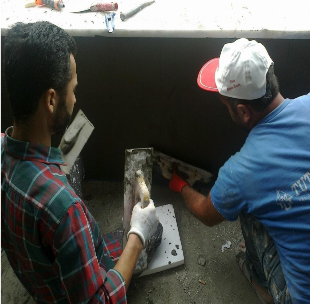
Şekil-34 Yapıştırıcı sıvanın düzeltilmesi
