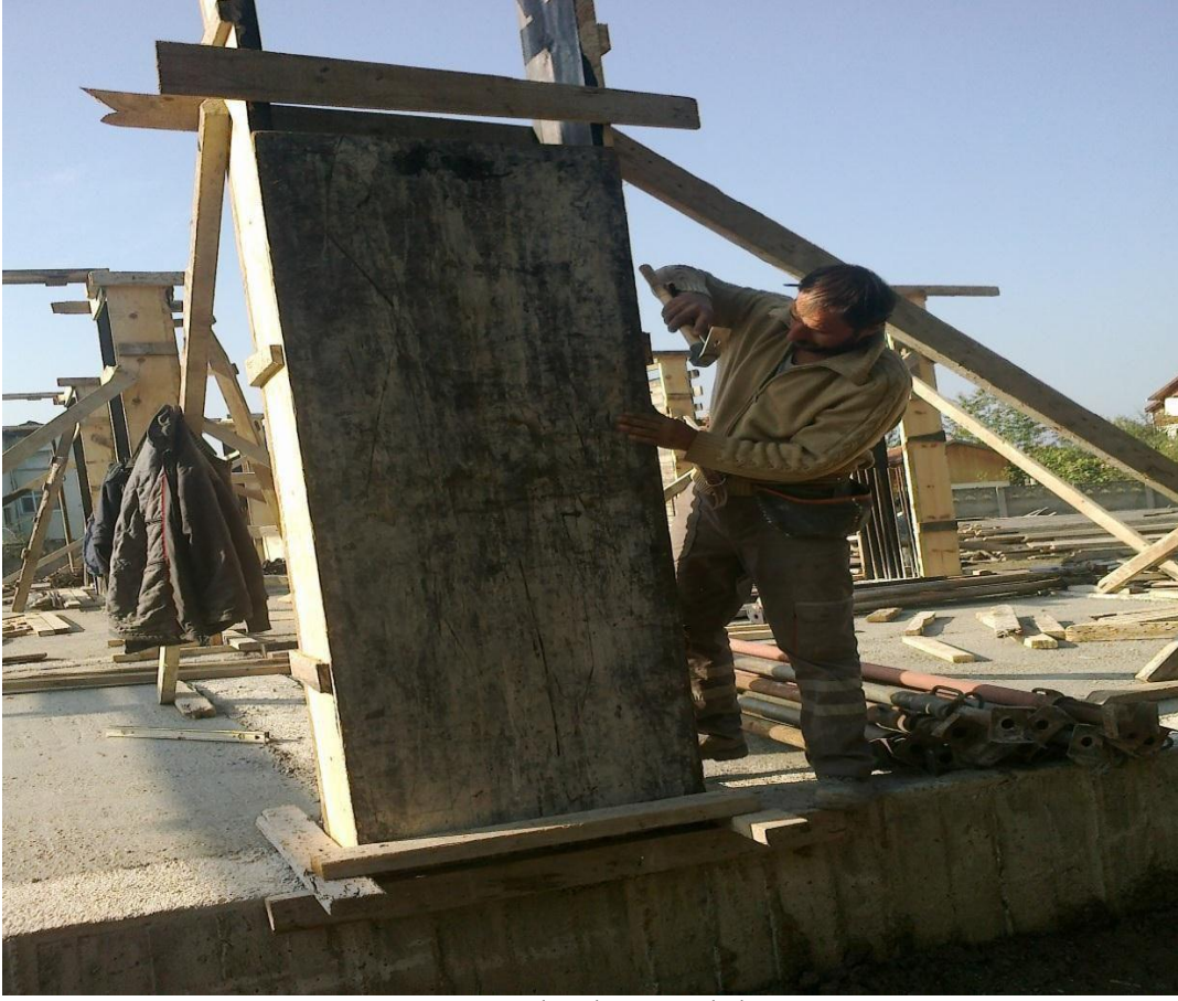
ğekil-70 Kolon kanat çakılması
