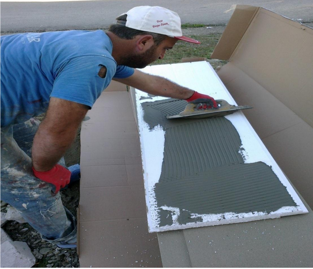
ğekil-27 Fugalı yapıÇtırıcı taraklanması
