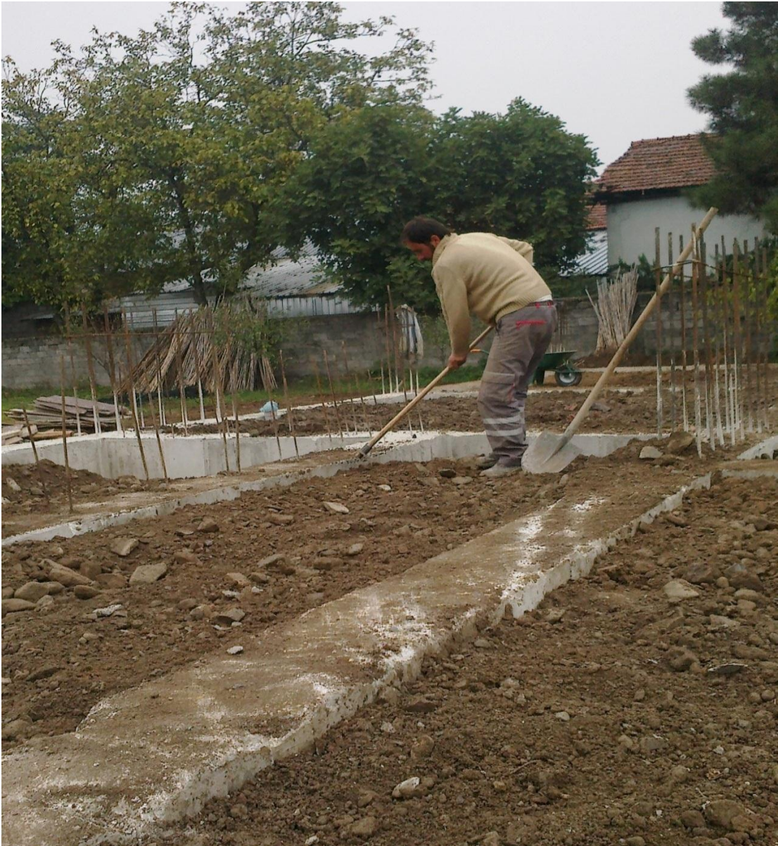
ğekil-82 Dolgu düzeltilmesi
