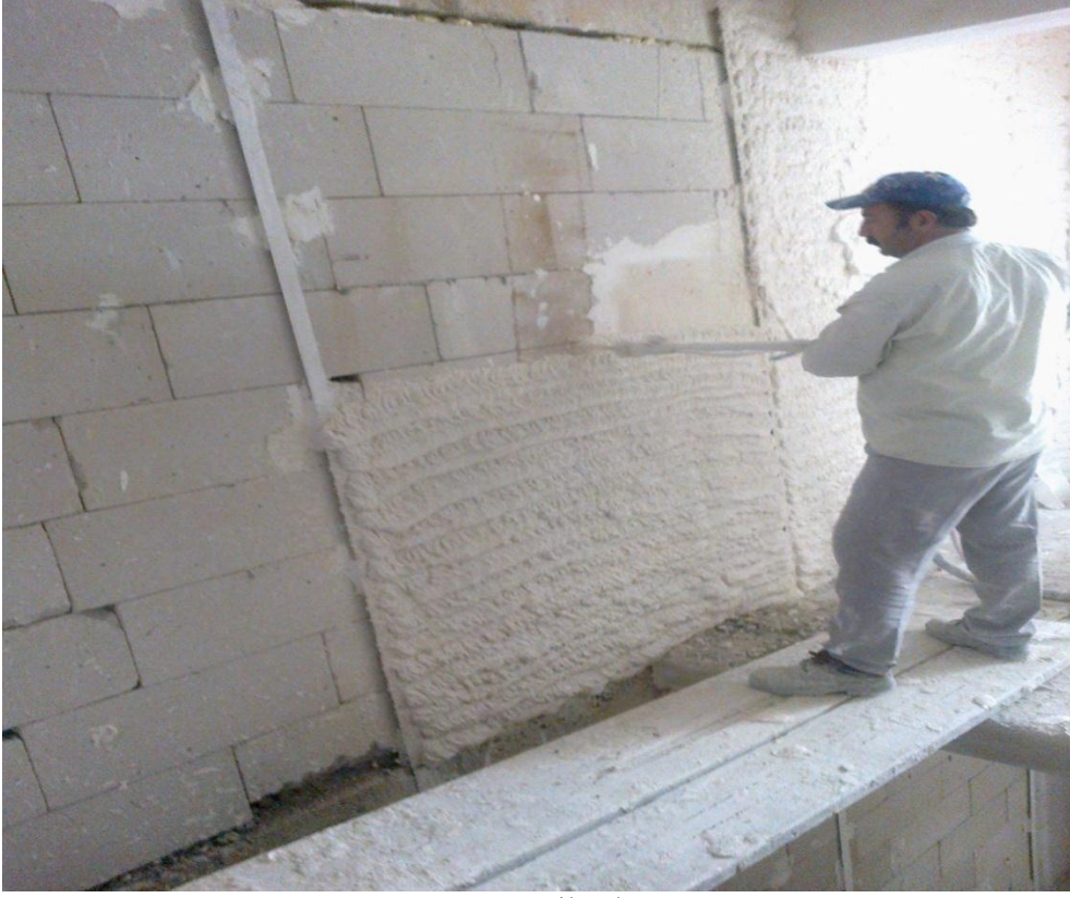
ğekil-7 Pompa ile alçı yapımı
