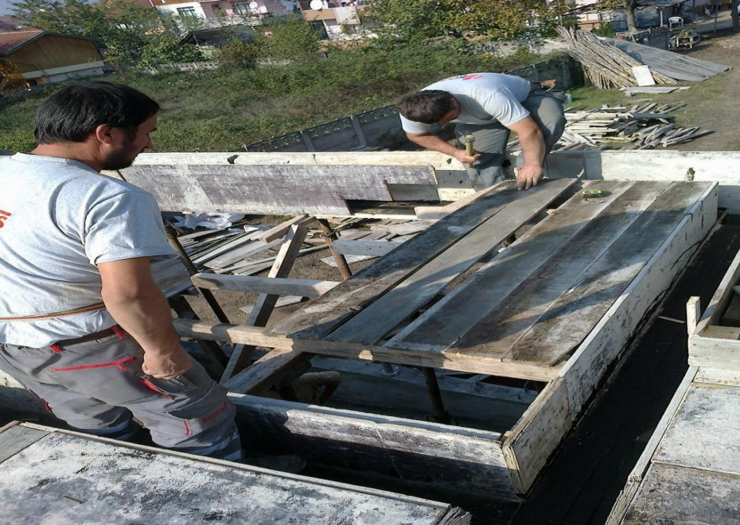
gekil-76 Üst kat sahanlık kalıp yapımı
