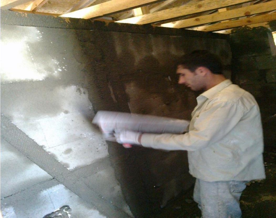
ğekil-19 Anoların yapılması
