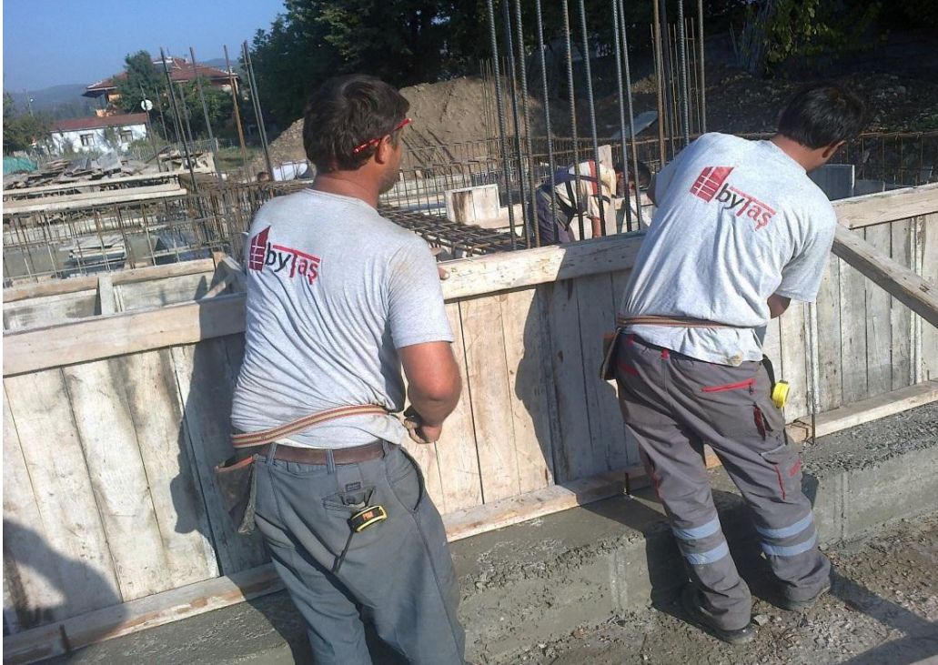
ekil-57 Kanatlara destek vurulması
