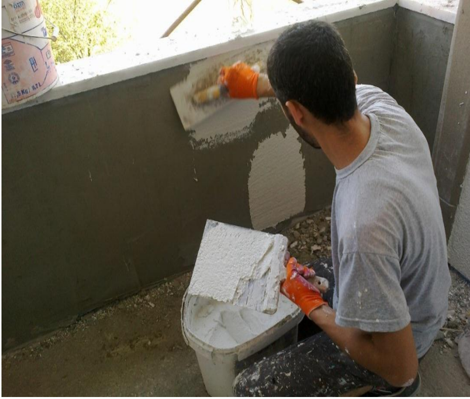
ękil-10 Dekoratif sıva sürülmesi
