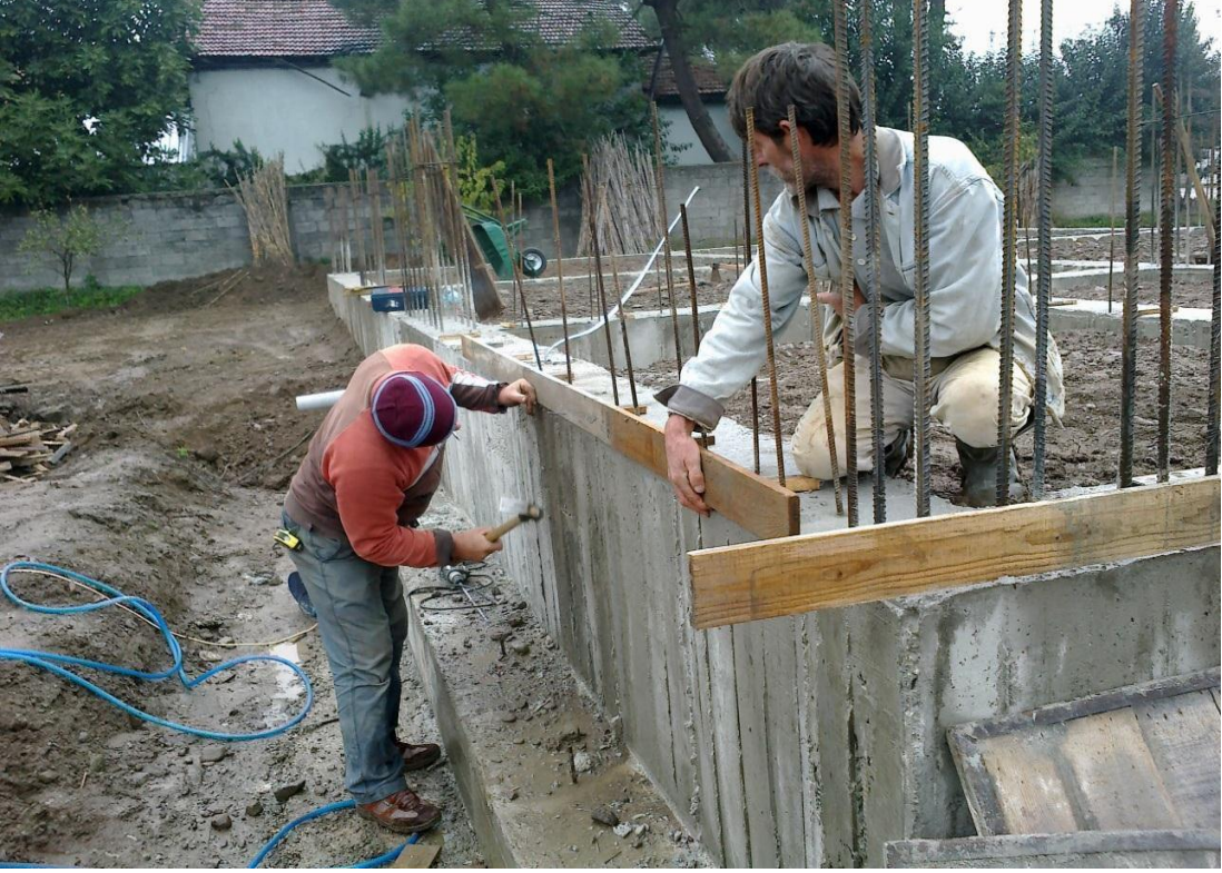
ğekil-60 Perde kanat yapımı
