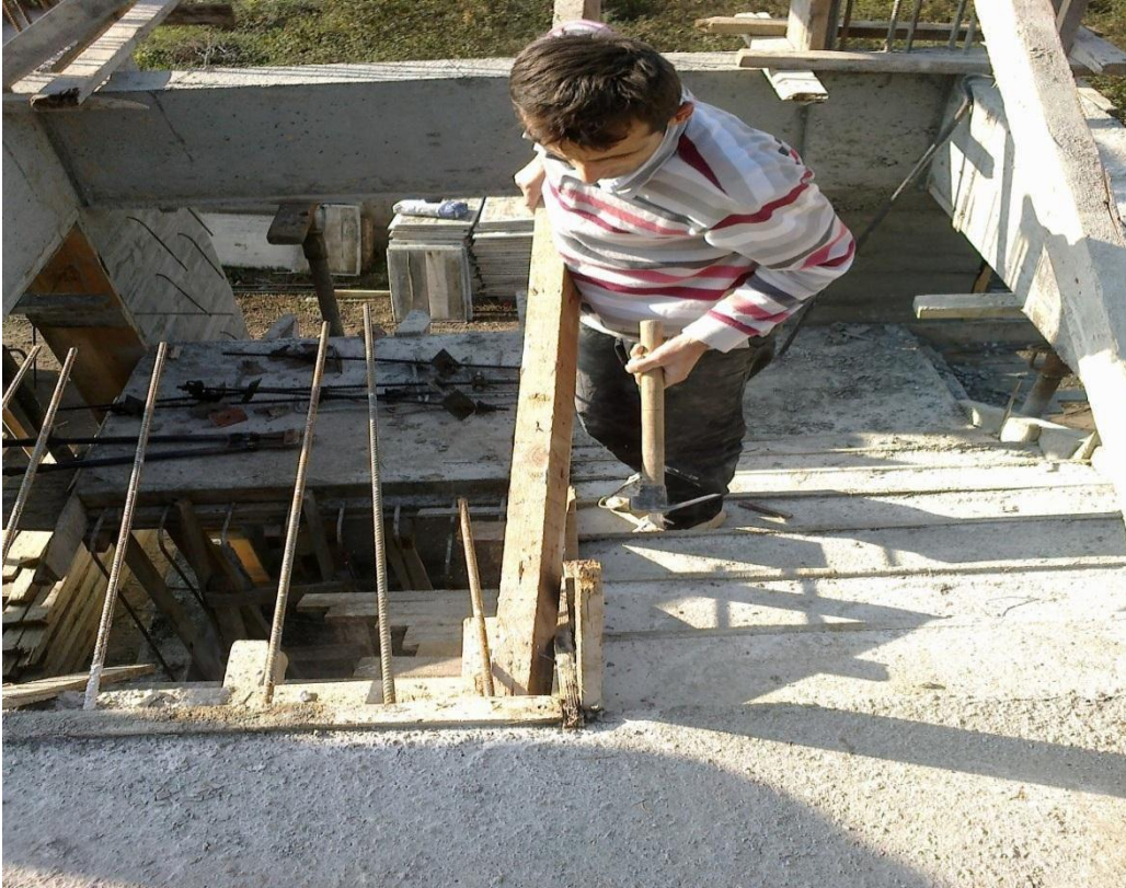
ğekil-79 Merdiven kalıp sökümü
