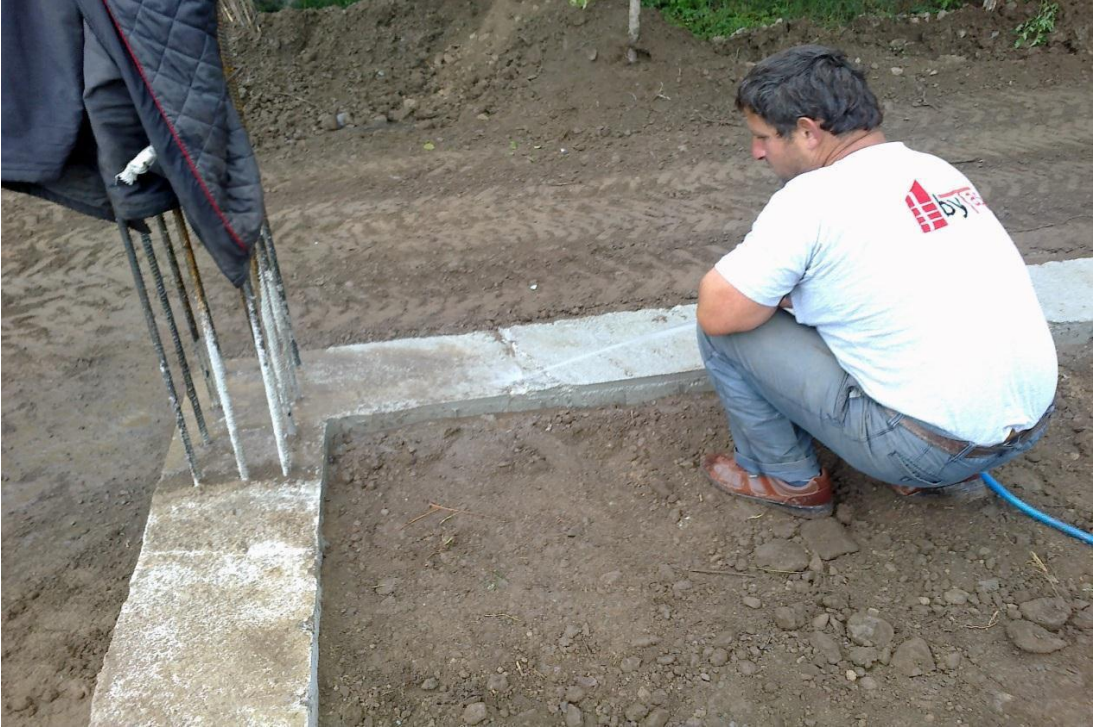
ğekil-84 Betonun sulanması
