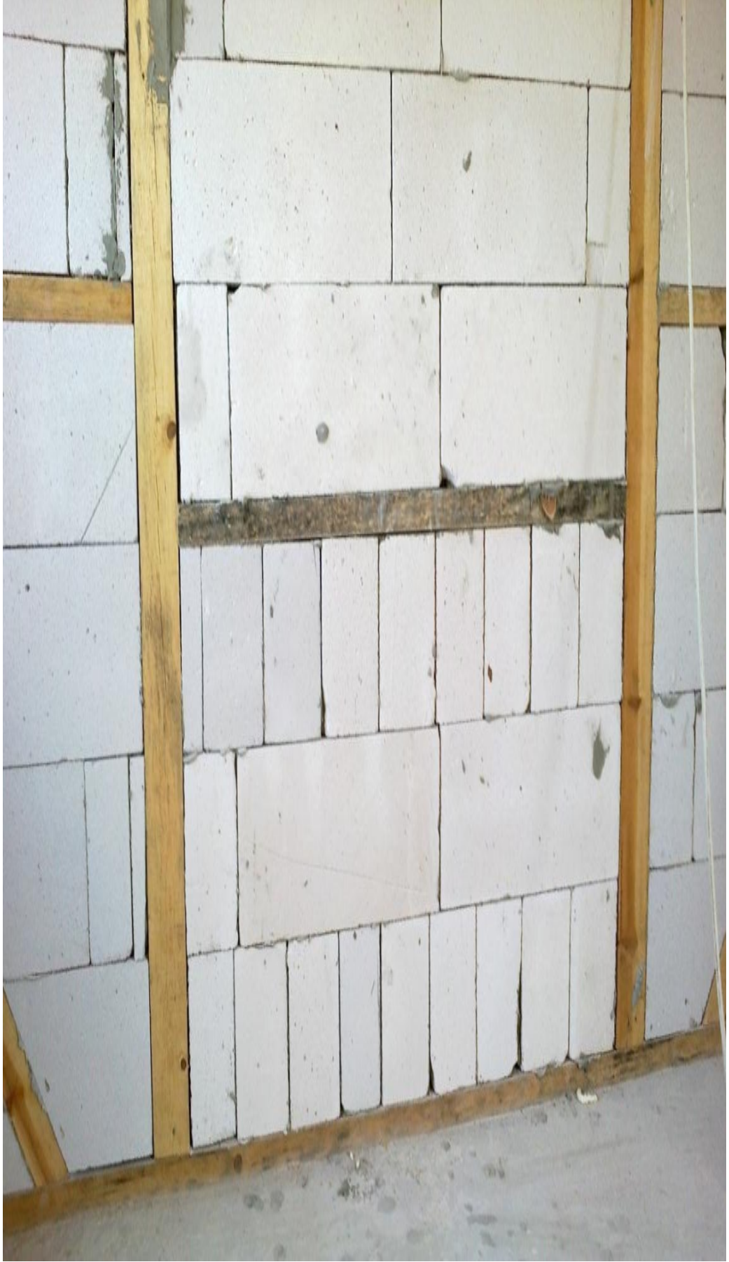
ğekil-1 Gaz beton duvar örümü
