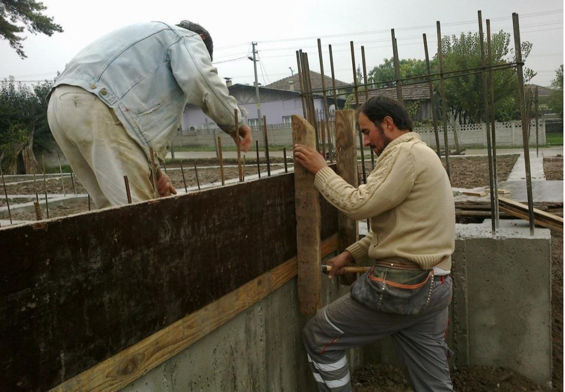
ğekil-61 Perde kanatlara destek yapımı
