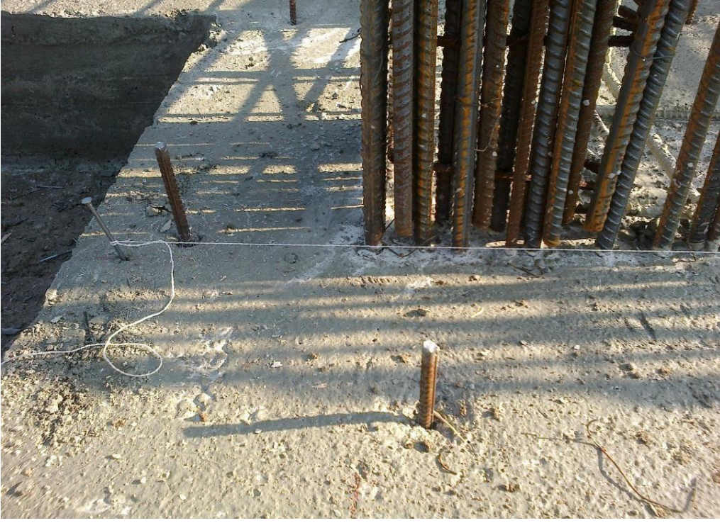
ğekil-54 Aks noktalarına ip çekilmesi
