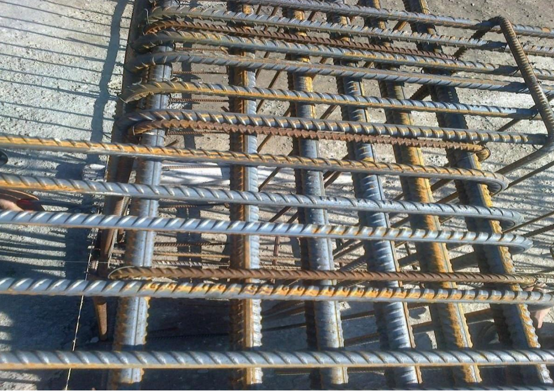
ğekil-48 Demir bağlanması
