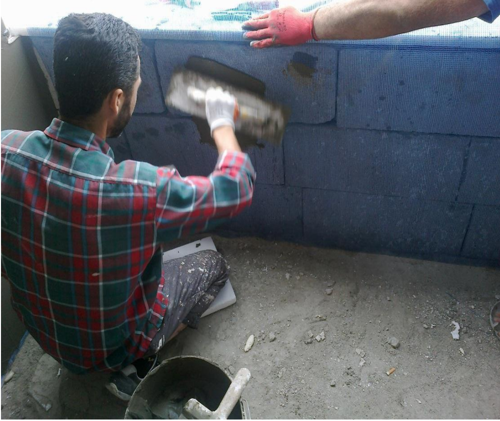
ğekil-32 File yapıřtırılması
