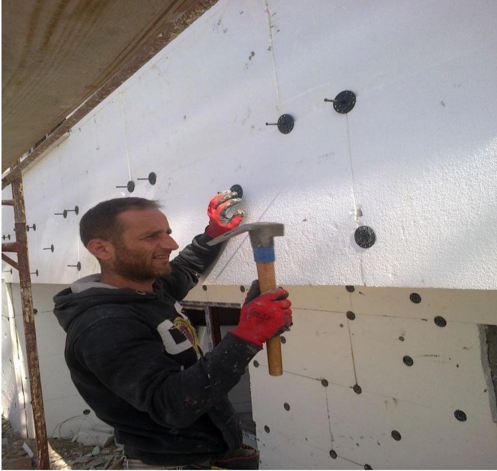
gekil-30 K p klere d bel atılması
