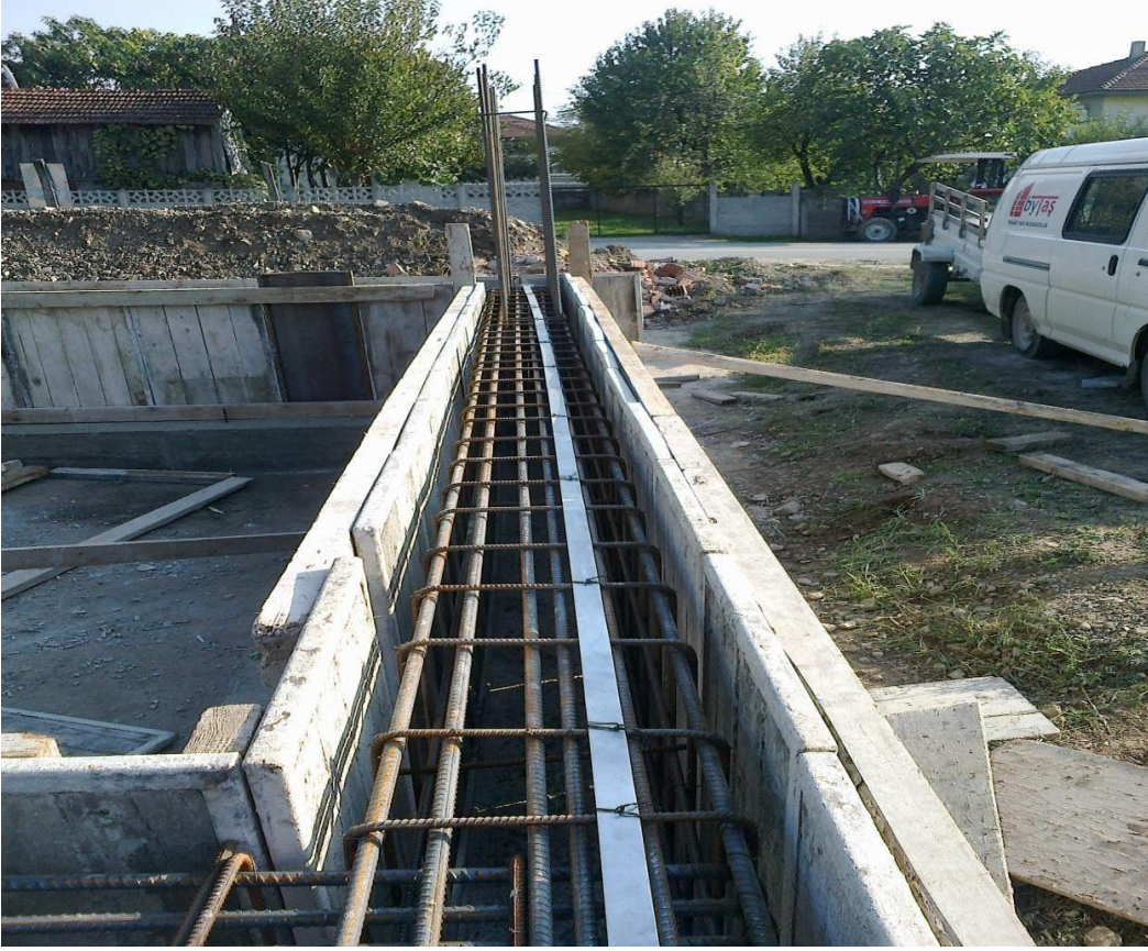
ğekil-58 Kanatların çift taraflı yapımı
