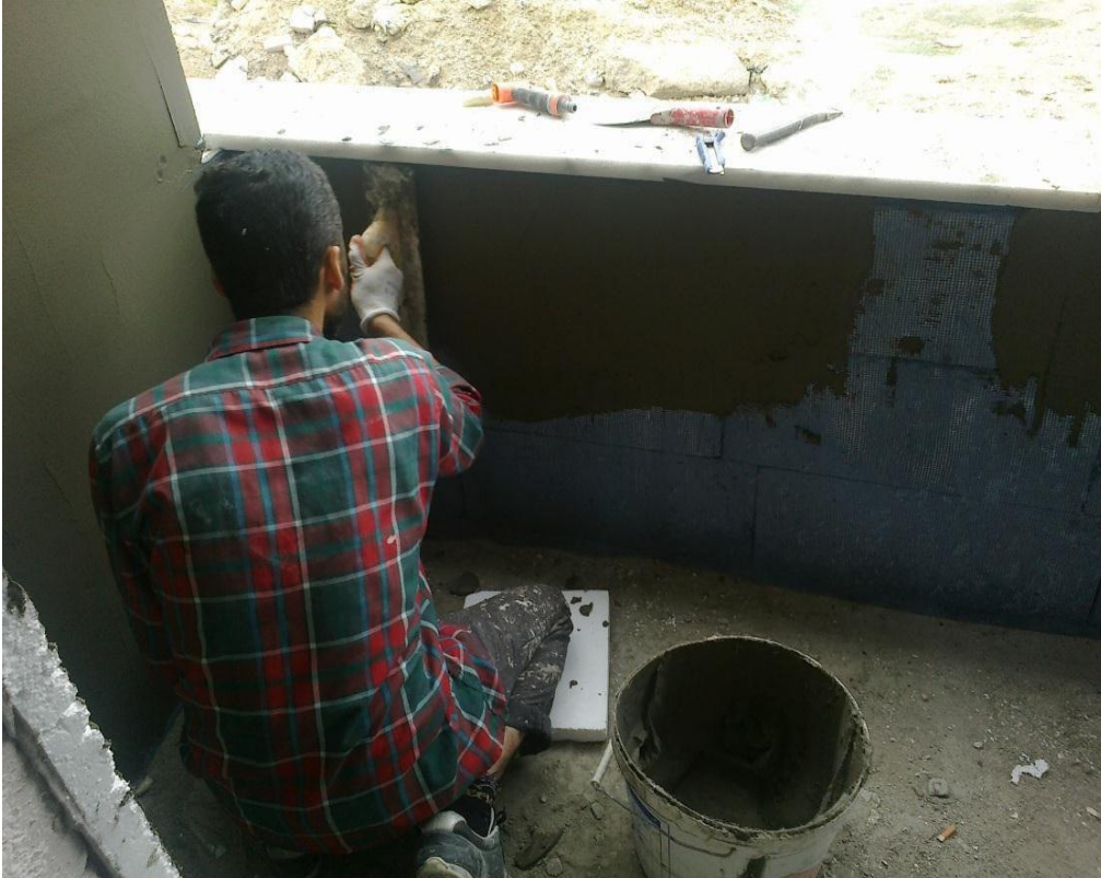
ğekil-33 Yapıřtırıcı sıva sürülmesi
