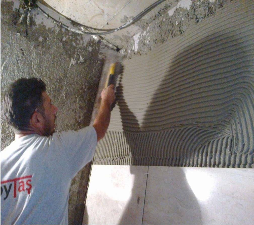
ğekil-15 Fayans harcının taraklanması
