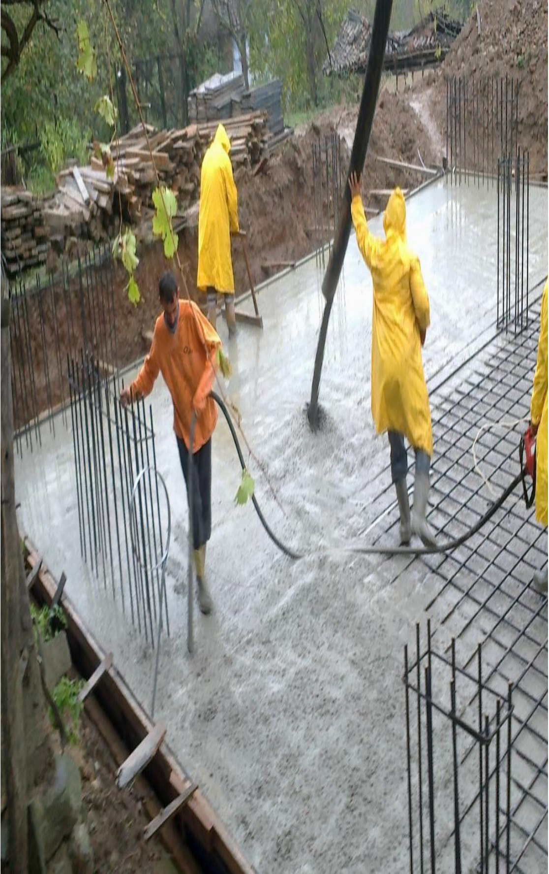
ğekil-89 Masterla beton düzeltilmesi
