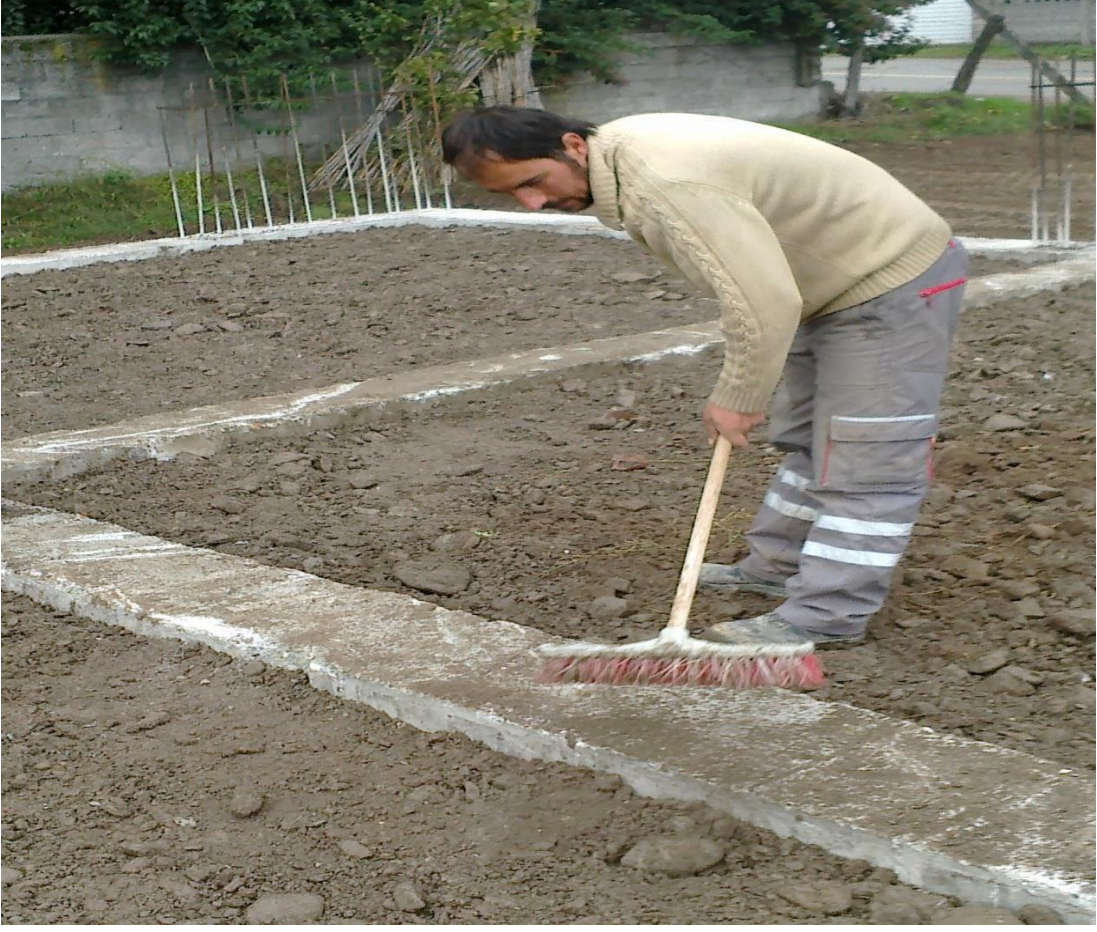
ğekil-83 Betonun temizlenmesi
