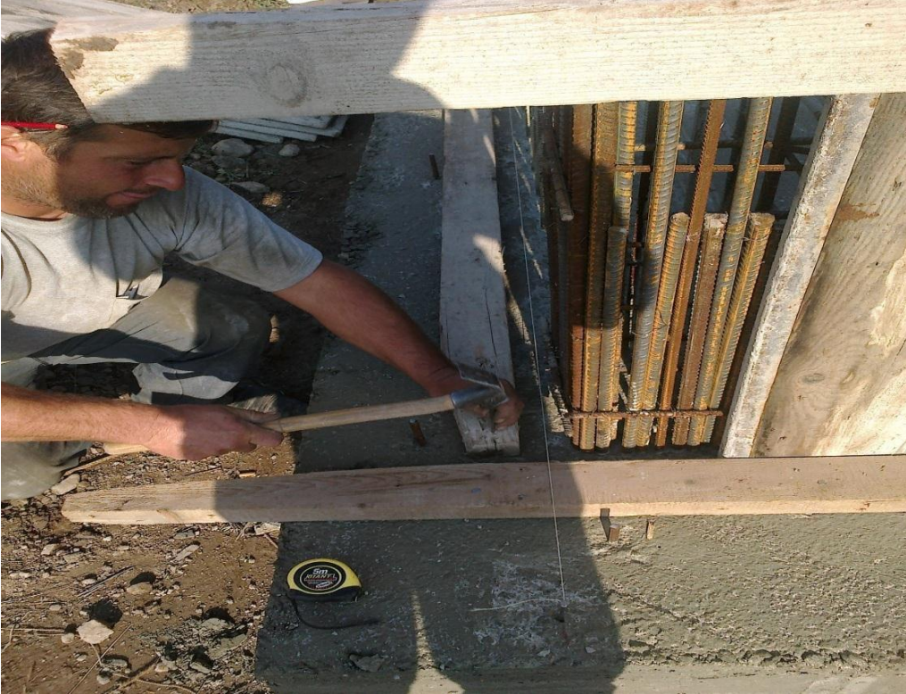
ğekil-55 Aks noktalarına 5*10 vurulması
