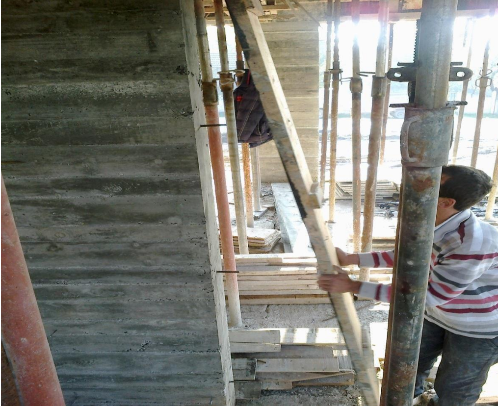
ğekil-78 Kolon yanaklarının sökümü
