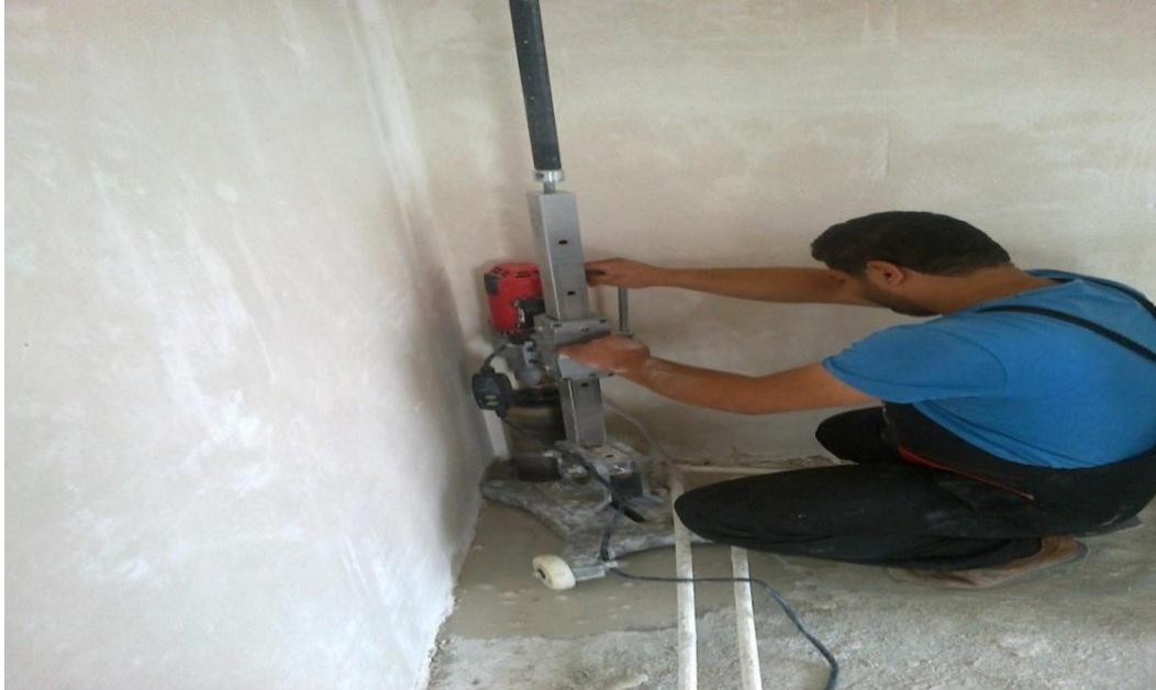
gekil-21 Karot makinesi ile dđeme delinmesi
