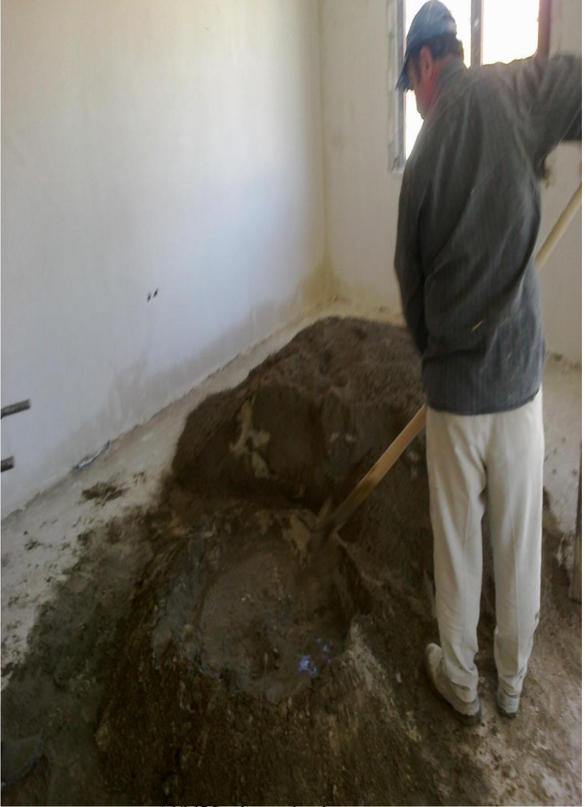
Şekil-17 Sıva harcının hazırlanması
