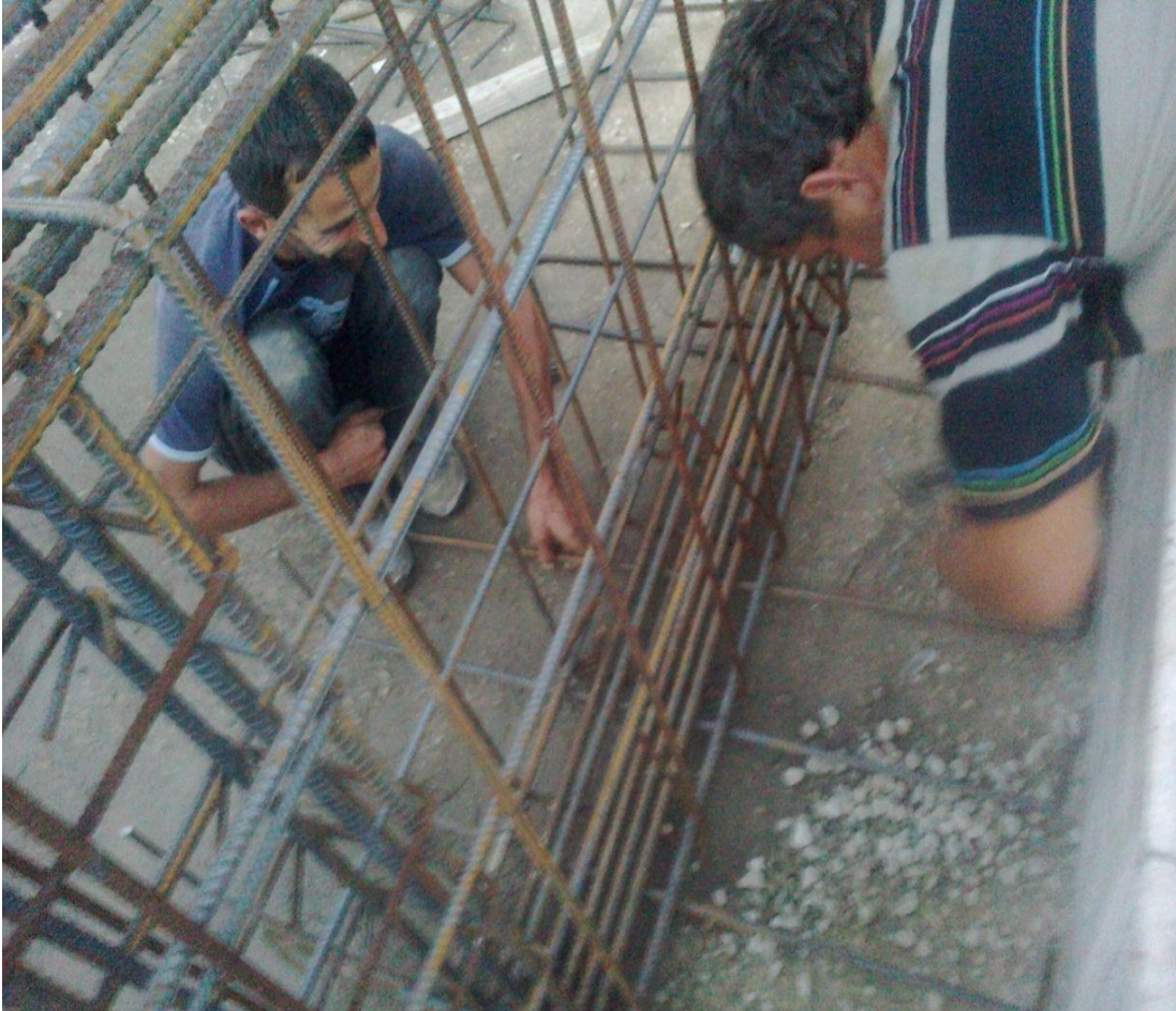
ğekil-53 Izgara demirlerinin bağlanması
