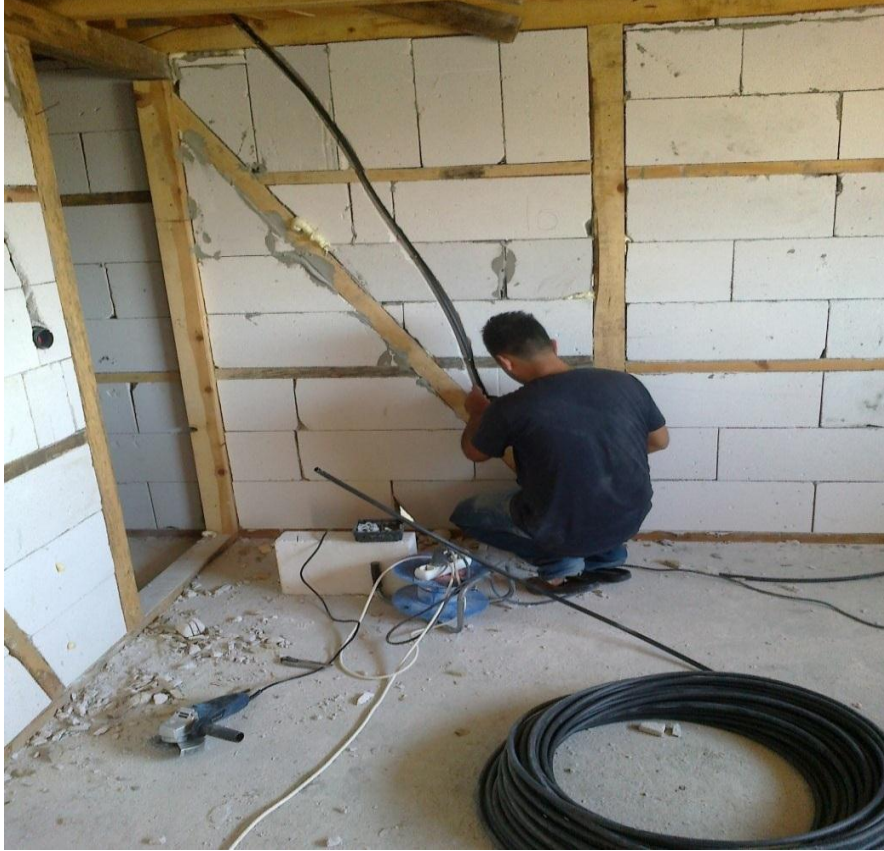
Şekil-12 Elektrik kabloları döşemesi
