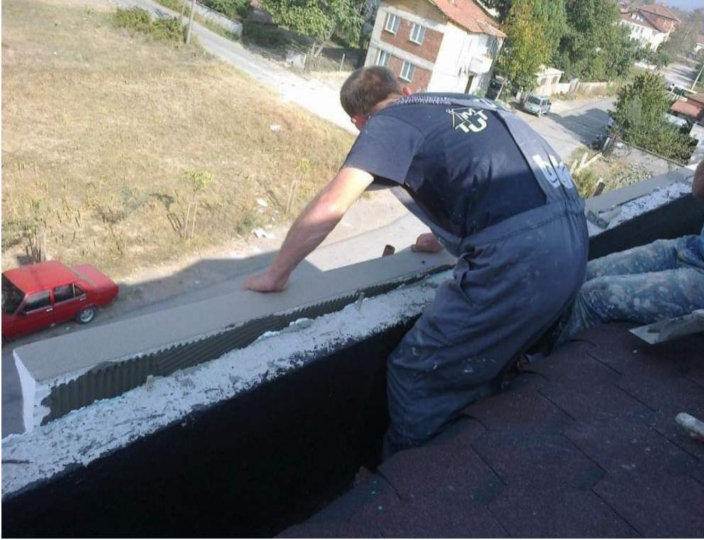
Şekil-3 Söve yapıldırılması
