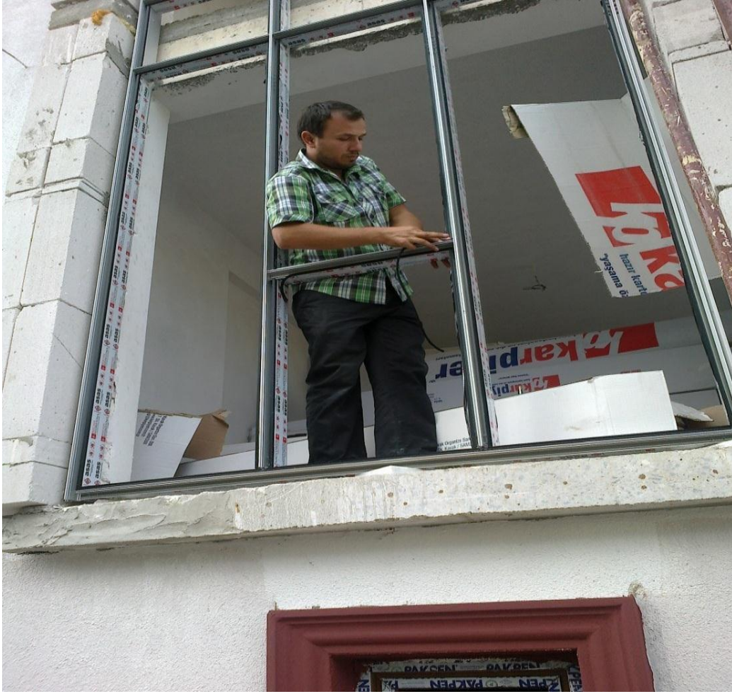
ğekil-43 Doğrama filtrelerinin takılması
