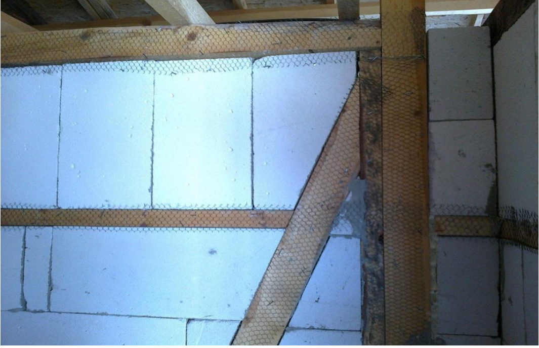
ğekil-18 Rabitz tel yapıÇtırılması
