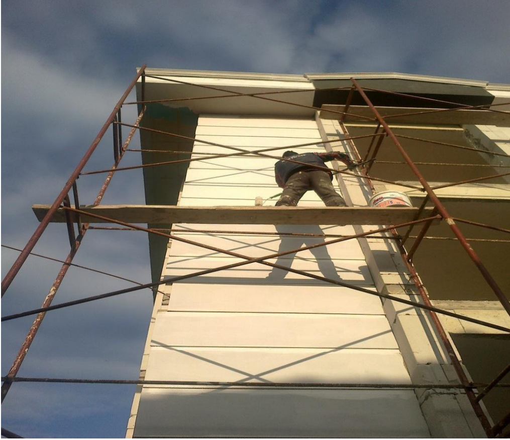
ğekil-39 DıĖ cephe boya yapımı
