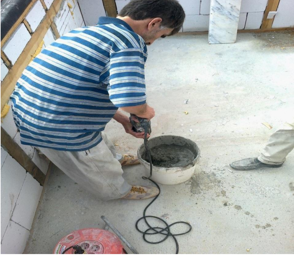
ğekil-35 Mermer harcının hazırlanması
