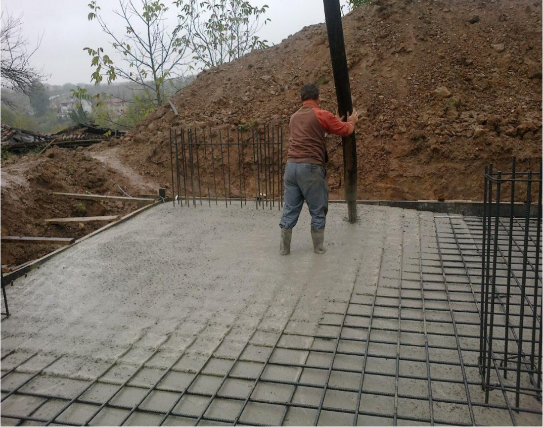
ėekil-87 Pompa ile beton d k m 
