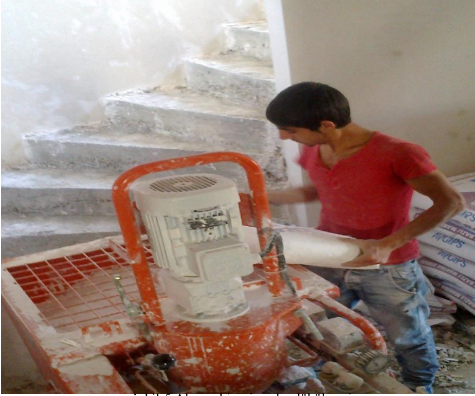
gekil-5 Alçı makinesine alçı dökülmesi
