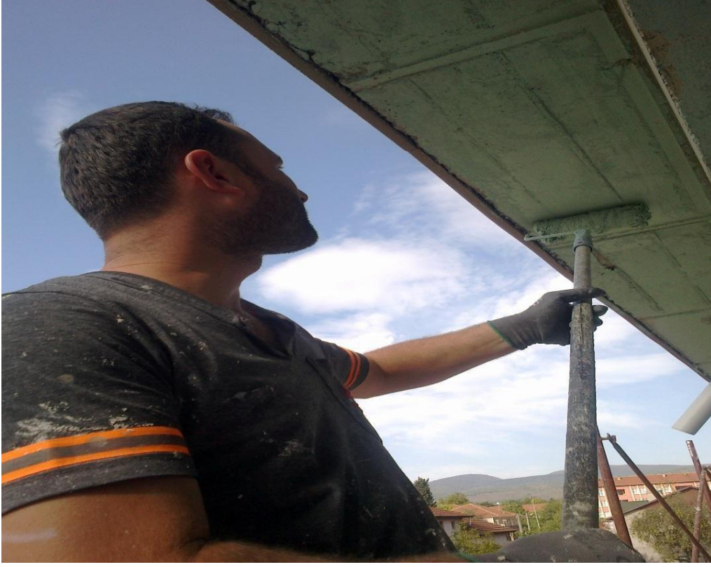
ęekil-44 Betokontak sürümü
