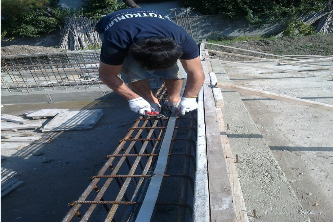
ğekil-86 Levhaların donatıya bağlanması
