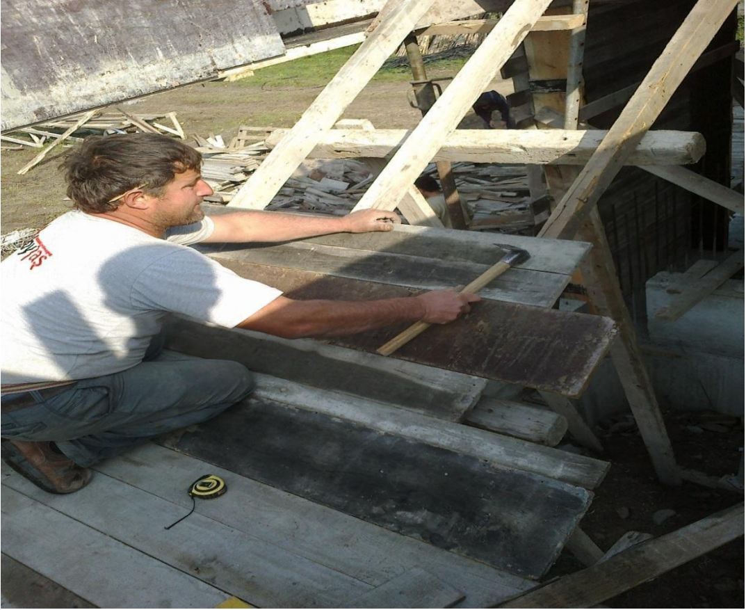
gekil-75 Basamak kalıp yapımı
