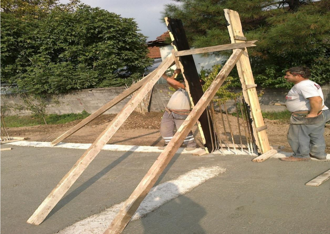
ğekil-69 Kolon yanaklarına destek yapımı
