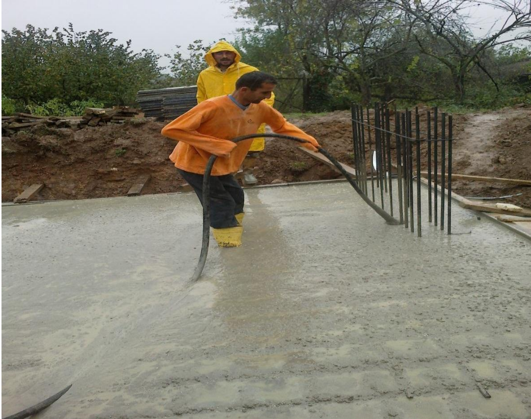
ğekil-88 Vibratör kullanımı
