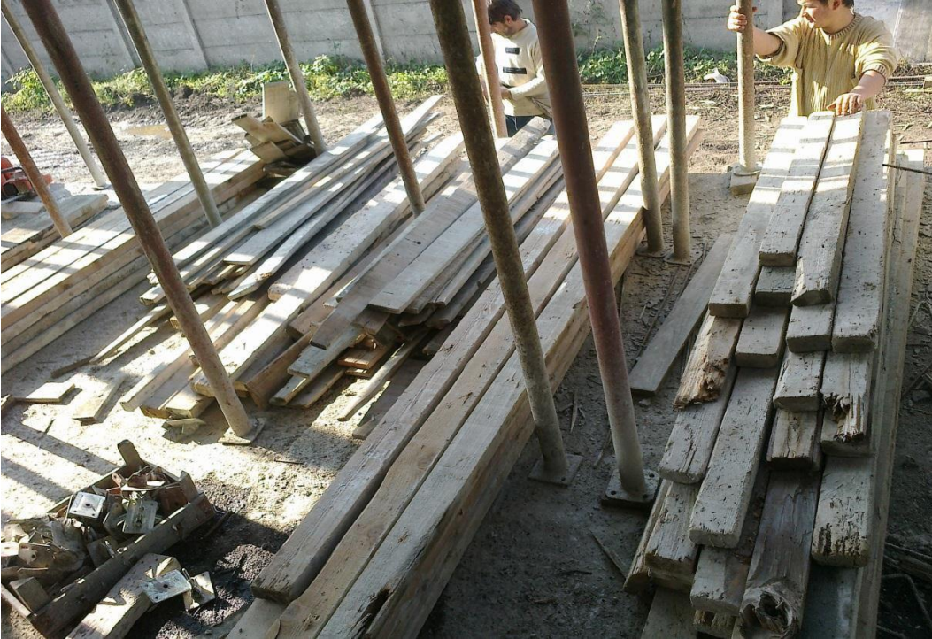
ğekil-81 Kalıpları istiflenmesi
