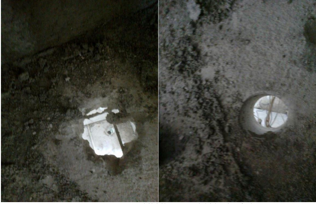
ğekil-24 Karot ve hilti ile arasındaki kesim farkı
