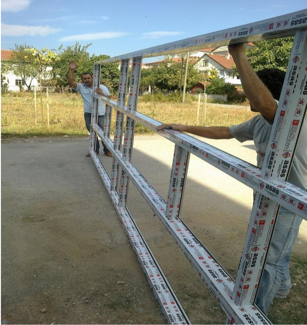
Şekil-40 Doğramanın kaldırılması
