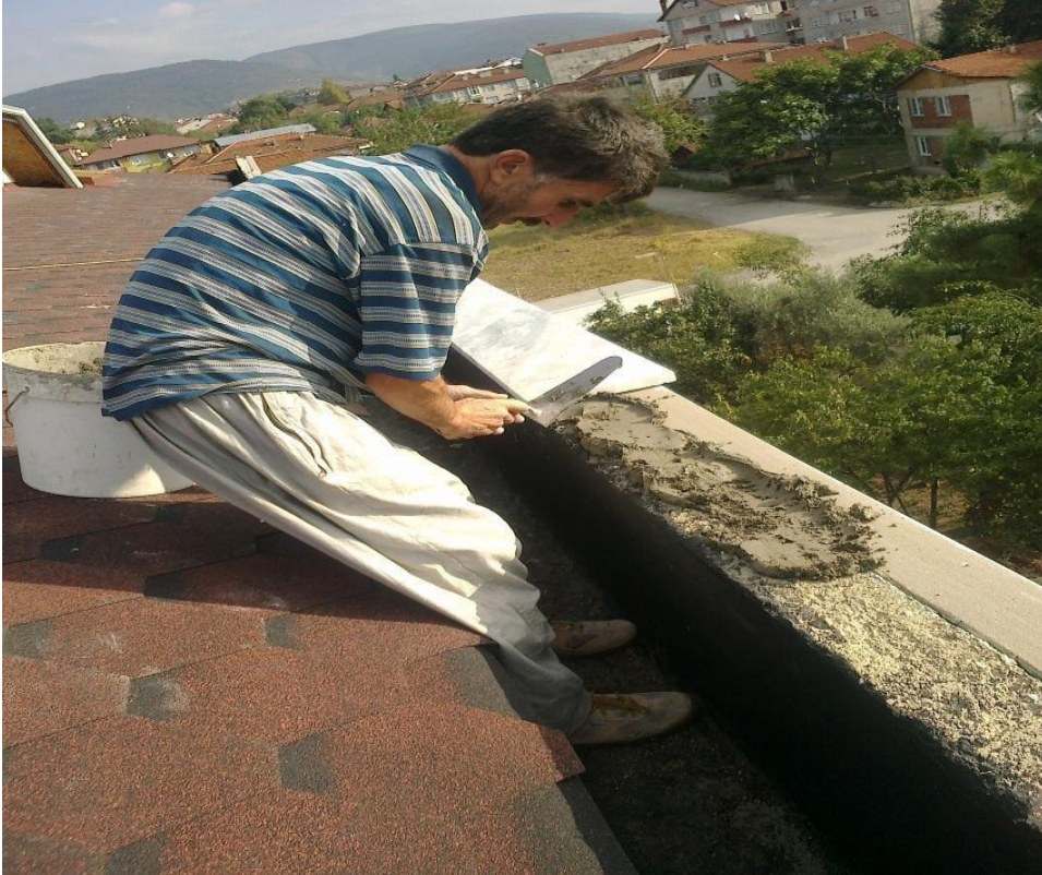
ğekil-36 Harcın yüzeye sürülmesi
