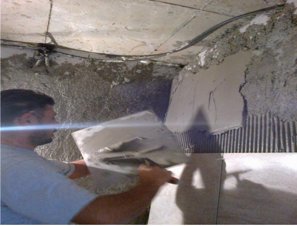
ğekil-14Harcın duvara sürülmesi
