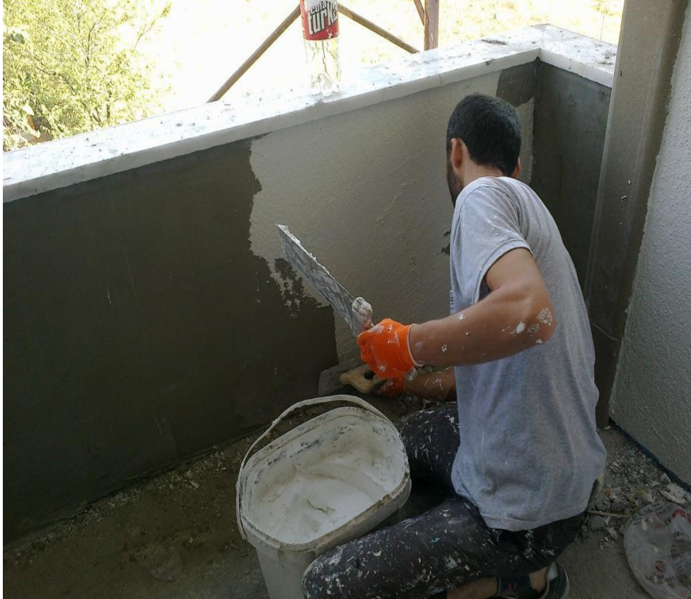
ękil-11 Dekoratif sıva düzeltilmesi
